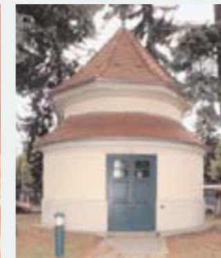
Der Neue Brunnen, gebaut im Jahr 1916.
